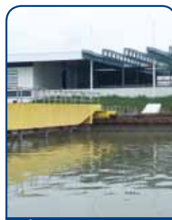
Завод по очистке сточных вод, Лион, Франция, изделия большого диаметра
