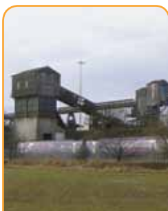
Угольная шахта Hatfield, Великобритания, Демонтажные вставки
